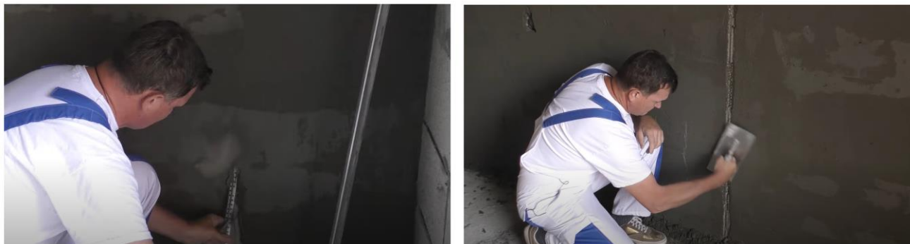
Рис. 33. Схема демонтажа маяков и заделки образовавшихся борозд
