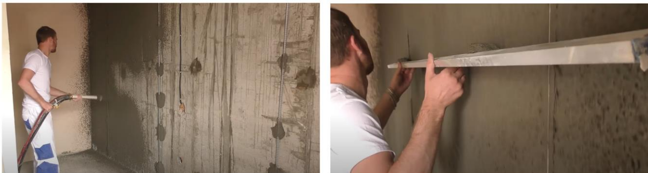
Рис. 31. Схема нанесения обрызга на поверхность и разравнивание правилами образовавшихся наплывов
