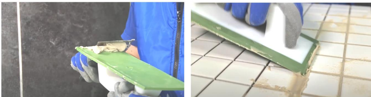
Рис. 39. Заполнение швов затиркой при помощи резинового шпателя
